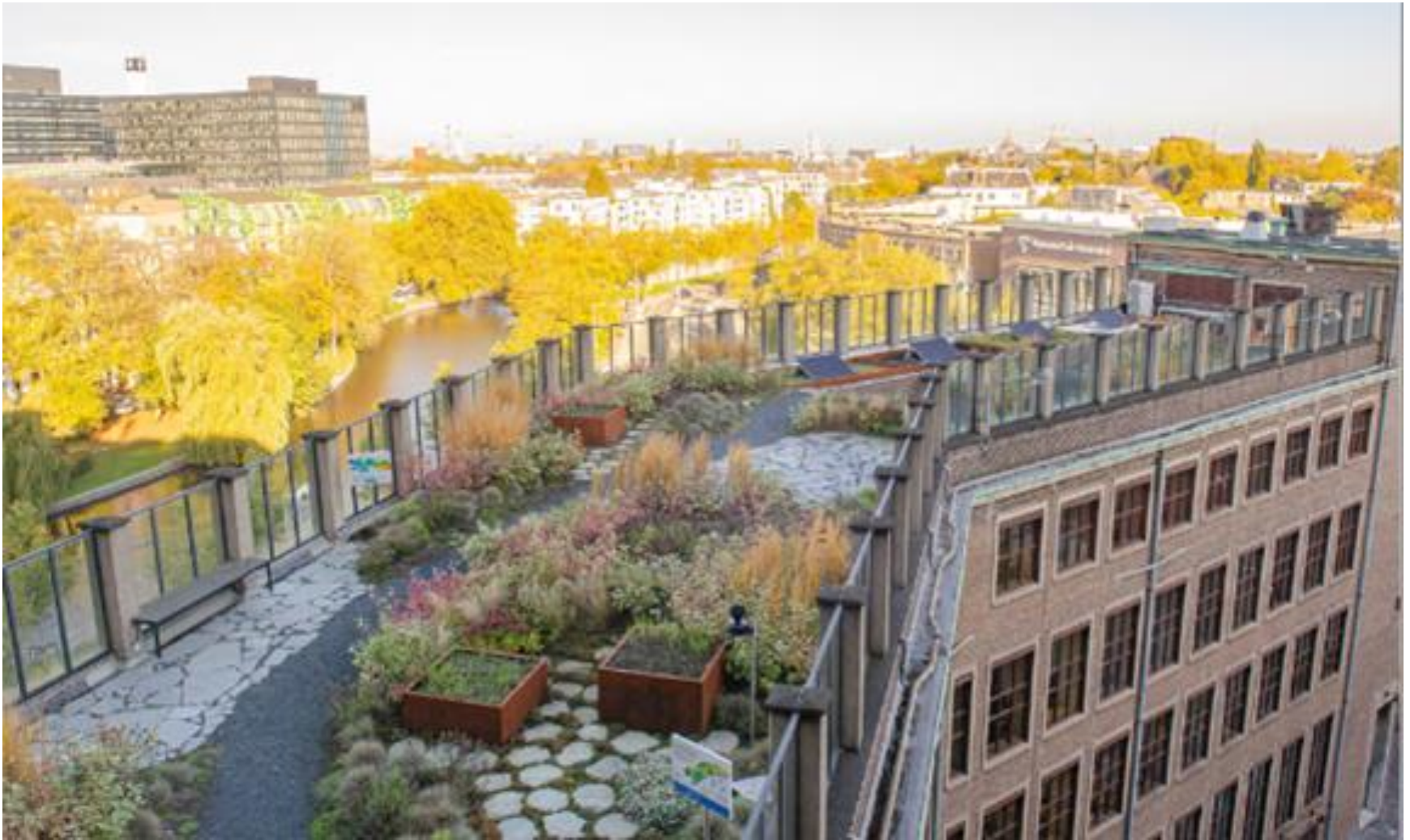
Cobertura inteligente do Premselahuis Innovation Lab, em Amsterdão, executada pelo RESILIO (autor da imagem: Wieke Braat). Fonte: https://www.uia-initiative.eu/en/news/journal-3-completing-and-delivering-resilio-smart-bluegreen-roofs-1
