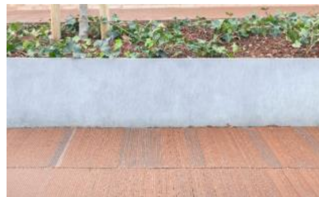
Pavimento cerâmico permeável instalado numa rua de tráfego ligeiro e pedonal em Benicàssim. Fonte: https://www.lifecersuds.eu/es/demostrador
